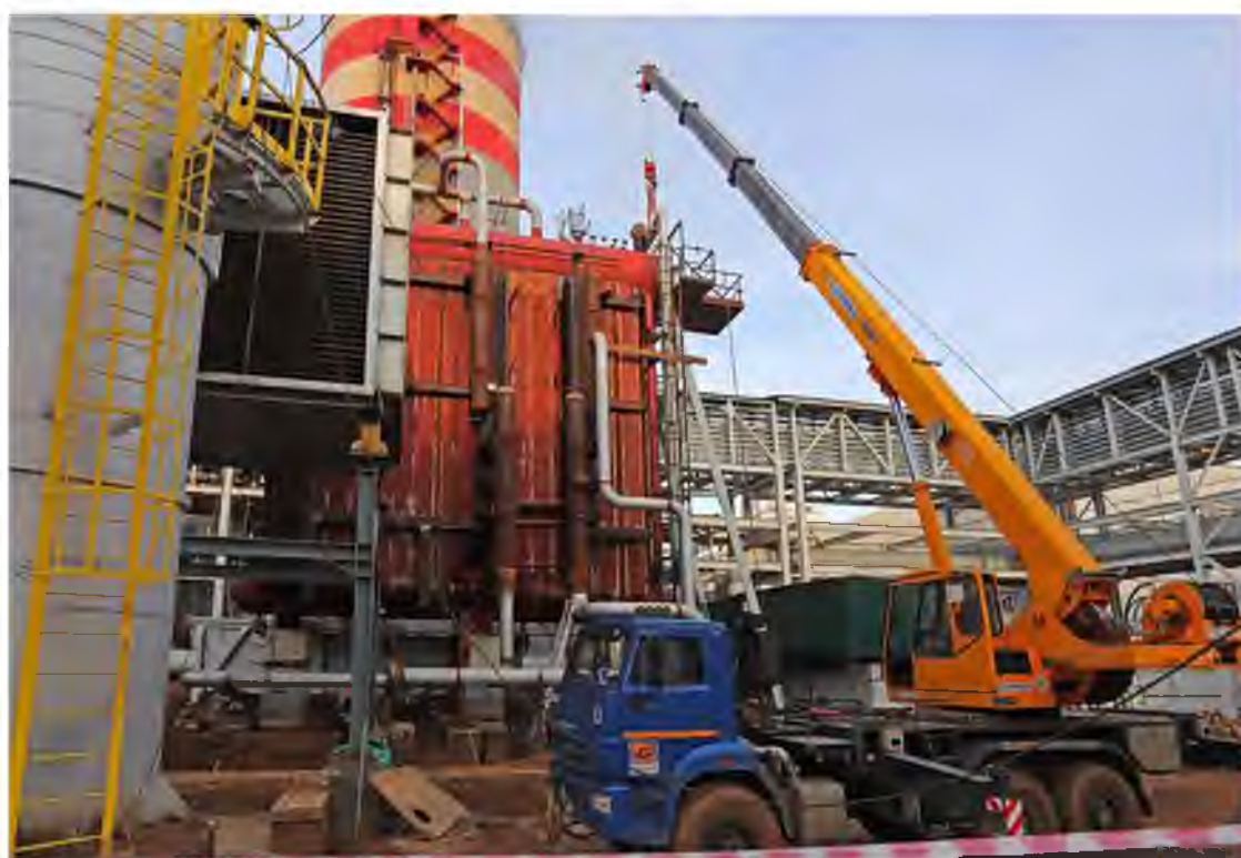
Мощность котла, который монтируют на будущем агрегате карбамида, превысит 136 тонн пара в час
